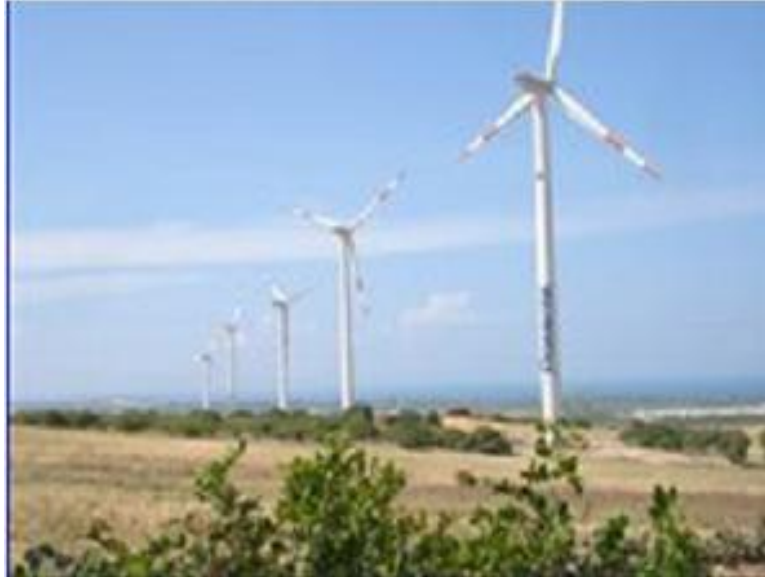
Hình 2. Năm tổ máy của nhà máy điện gió tầm cỡ MW đầu tiên ở Việt Nam ở xã Bình Thạnh, huyện Tuy Phong, tỉnh Bình Thuận. Chiều cao của mỗi cái tháp là 103,75 m và đường kính của cánh quạt là 37,5 m [5].
