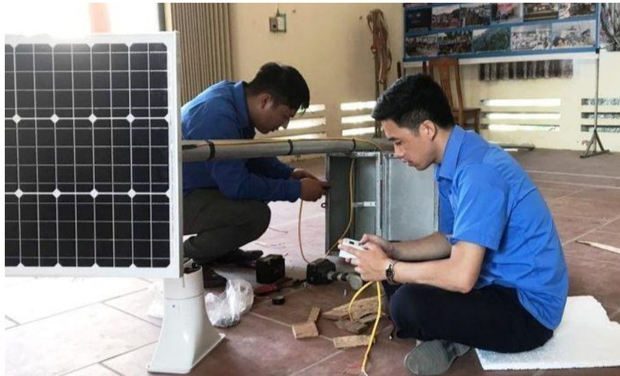
Lắp đặt Hệ thống cảnh báo đuối nước bằng năng lượng mặt trời
