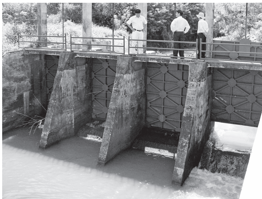
Các công trình thủy lợi lớn trên địa bàn tỉnh đang phục vụ tưới nước cho trên 20 ngàn ha đất sản xuất
