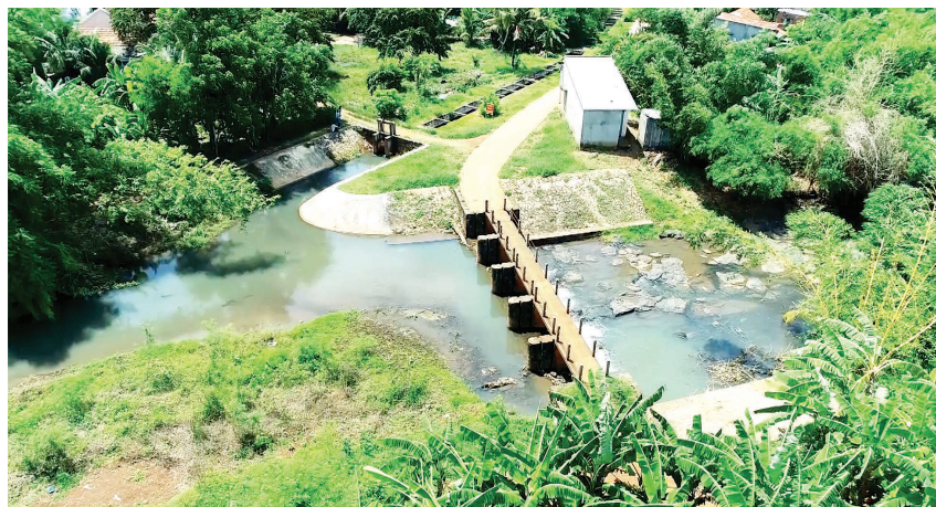
Công trình thủy lợi trên cánh đồng ở Sông Ray (huyện Cẩm Mỹ)
