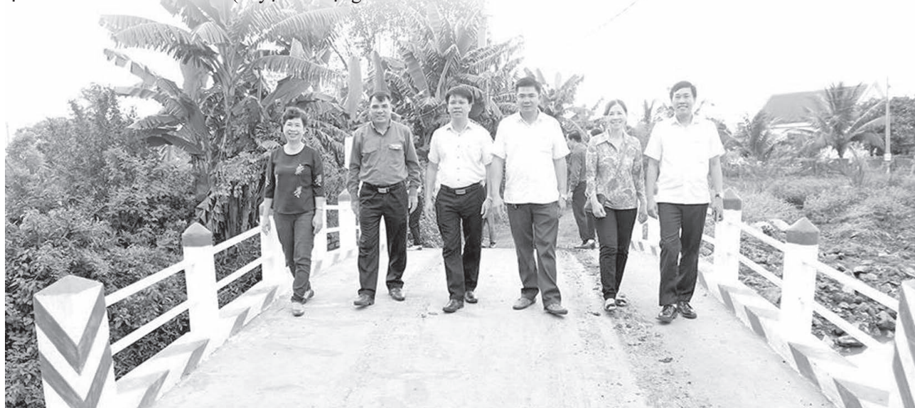
Cây cầu dân sinh tại xã Vĩnh Tân, huyện Vĩnh Cửu do Tỉnh đoàn vận động xây dựng
