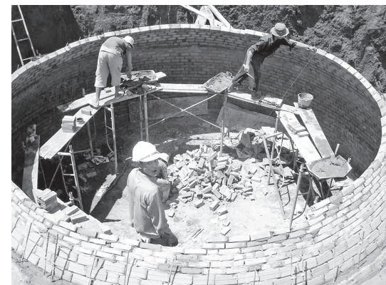
Xây dựng hầm biogas để xử lý chất thải trong chăn nuôi.
