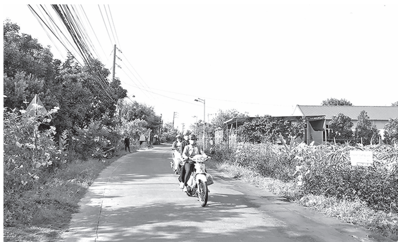
Tuyến đường Mã Voi - Bưng Cẩn (H.Xuân Lộc) được lắp đặt hệ thống đèn chiếu sáng bằng năng lượng mặt trời
