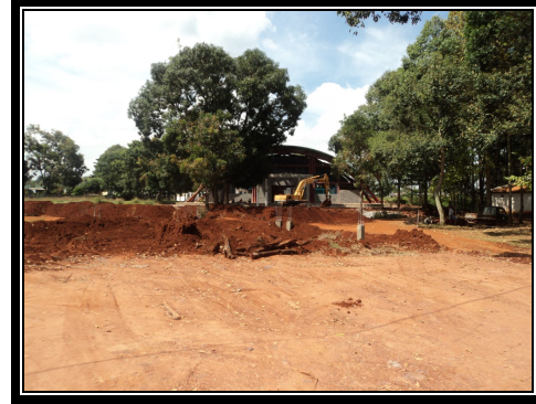
Công trường xây dựng khu lăng mộ.
