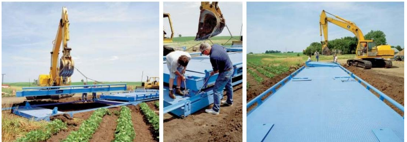
Hình 5: Quá trình lắp đặt cân trên nền đất yếu của hãng Avery Weigh – Tronix
