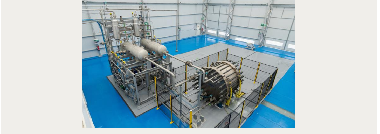
Máy điện phân kiểm điều áp do Nordex chế tạo. Ảnh: Nordex
