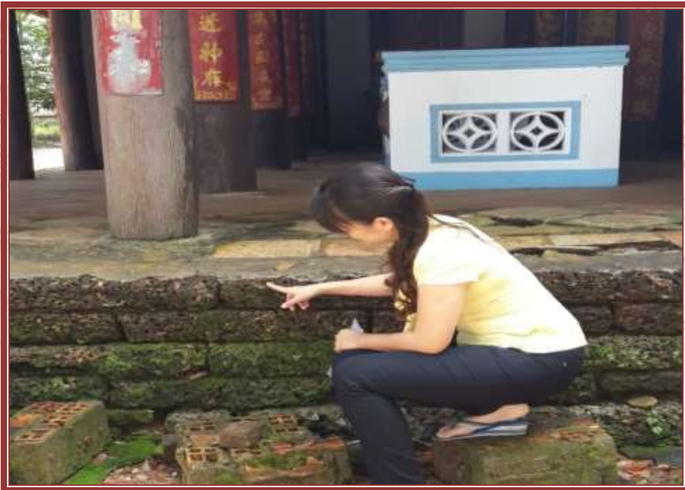
Tác giả xem móng và nền đình xây bằng đá ong
