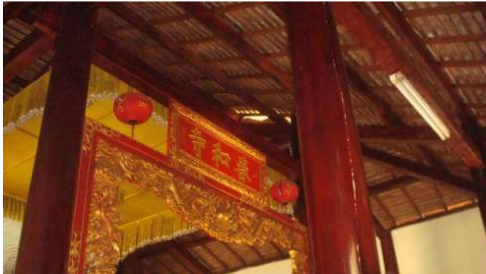
Cột, vì kèo, mái ngói chánh điện chùa Xuân Hòa
