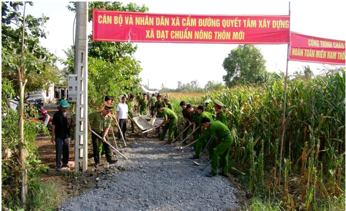
Lực lượng phối hợp đang tu sửa và san lấp đá dăm tuyến đường hẻm 427 thuộc tổ 4, ấp 1 xã Cẩm Đường, huyện Cẩm Mỹ.
