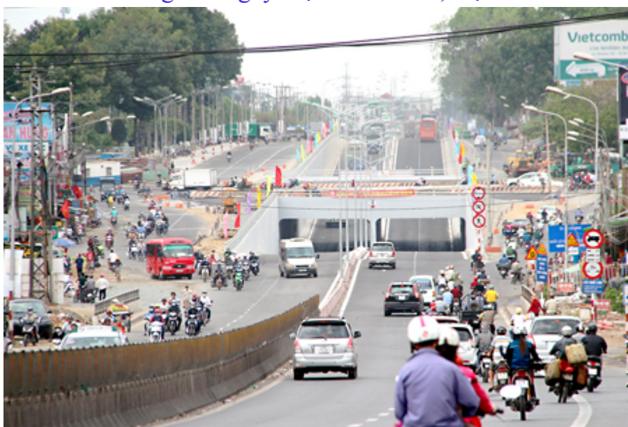
Hoàn thiện hạ tầng giao thông là một trong những nhiệm vụ quan trọng của Đồng Nai giai đoạn 2015-2020. Trong ảnh: Công trình hầm chui ngã tư Tam Hiệp, TP.Biên Hòa.
