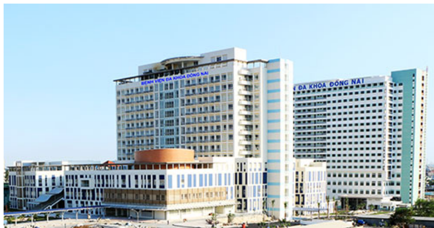
Bệnh viện Đa khoa Đồng Nai được xây dựng mới
