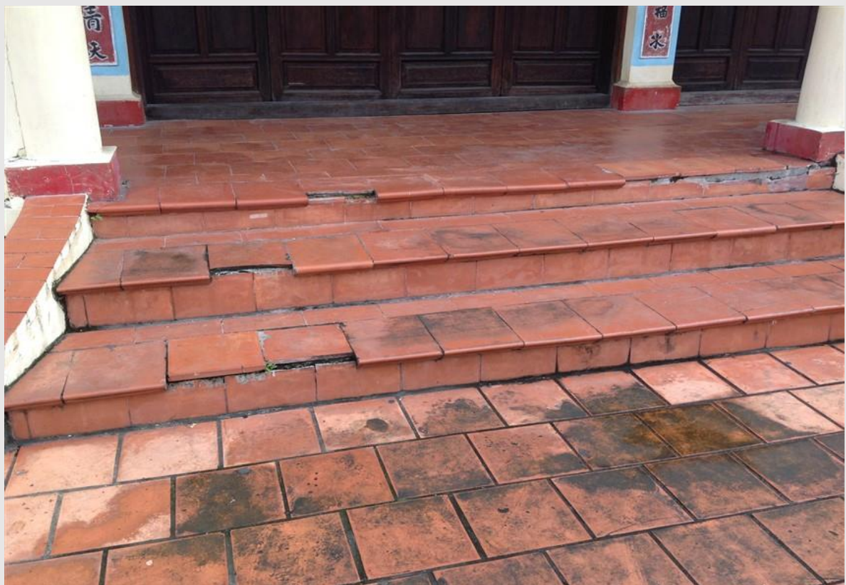
Mặt sân và nền nhà đã bị xuống cấp tại khu Đền thờ Nguyễn Hữu Cảnh ở Cù Lao Phố
