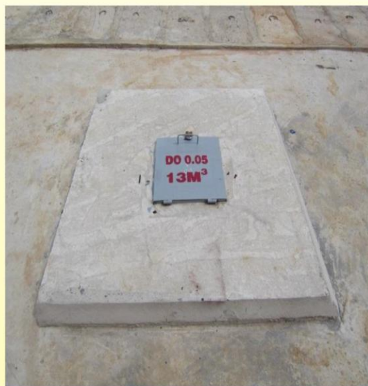
Bể chứa nhiên liệu có ghi cụ thể tên nhiên liệu và dung tích chứa
