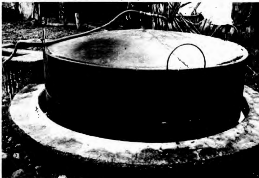
Hầm biogas nắp nổi
