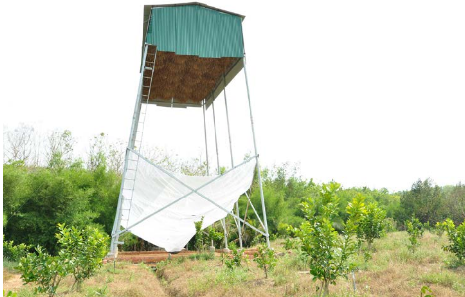
Một chòi nuôi dơi được bác sĩ Hoài và cộng sự xây dựng.
