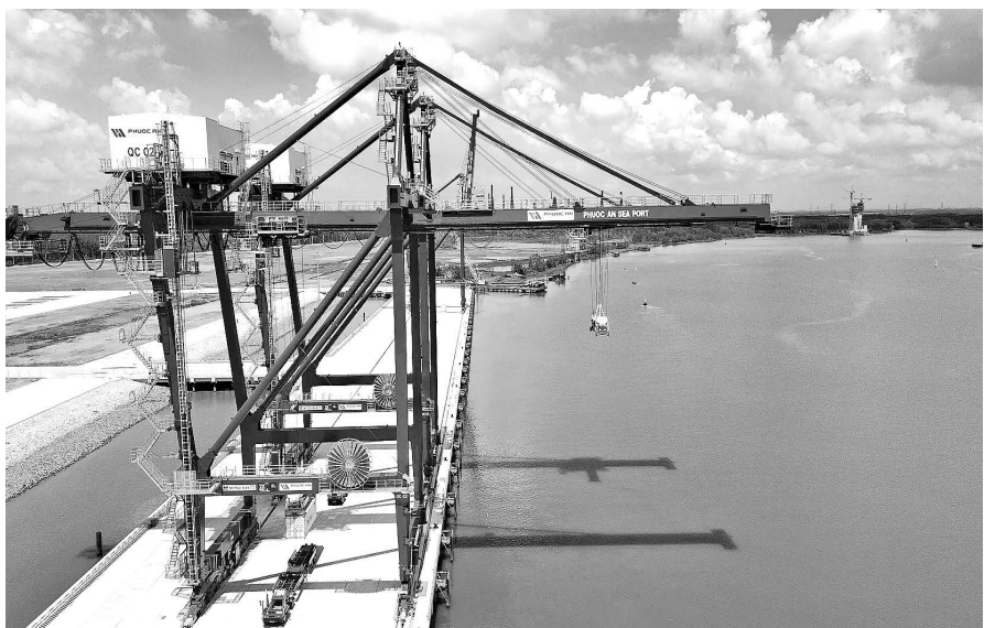
Cảng Phước An rộng 183 ha nằm bên bờ sông Thị Vải (huyện Nhơn Trạch) là cảng biển lớn nhất Đồng Nai được đưa vào khai thác từ tháng 9/2024
