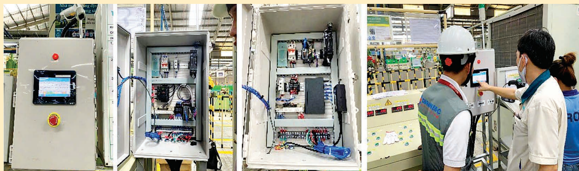
Hình ảnh lắp đặt hệ thống tại nhà máy
